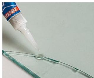
Une vitre brisée dont les morceaux sont en place doit être remplacée. En attendant, vous pouvez consolider l'ensemble pour éviter que les morceaux ne finissent par tomber. Pour cela, procurez-vous de la colle cyanoacrylate liquide et faites-la pénétrer délicatement à l'intérieur des fissures.
